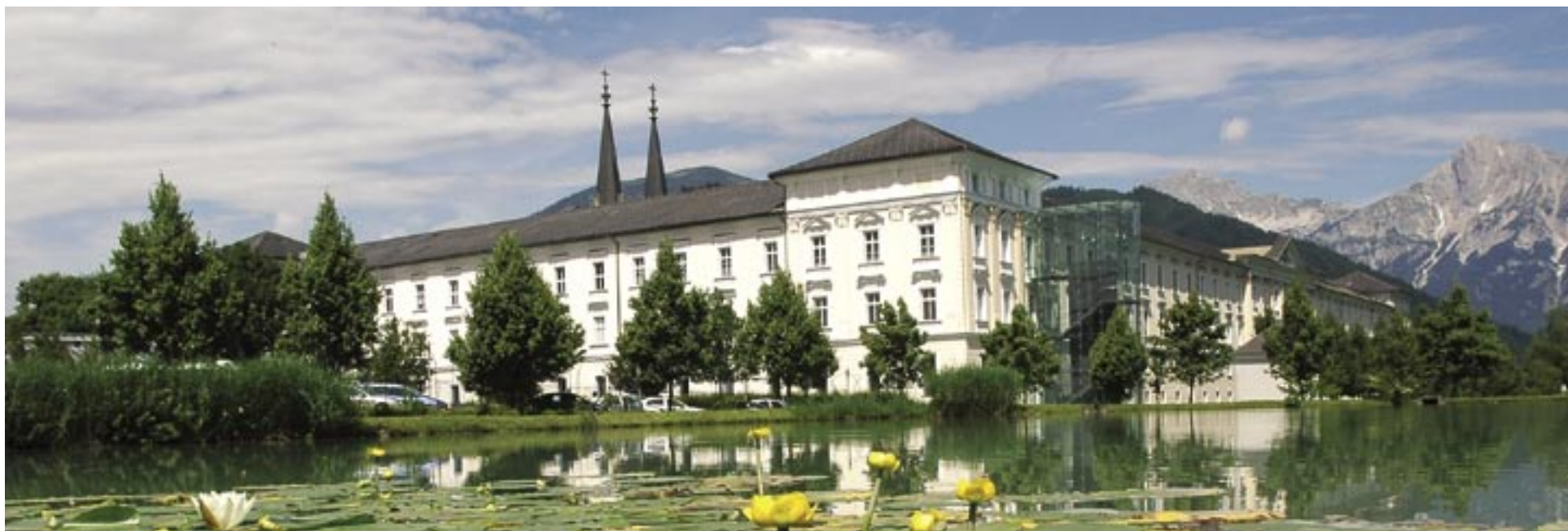
Benediktinerstift Admont • Ansicht von Südosten mit Stiftsteich
